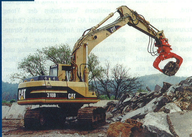
Der Cat Hydraulikbagger 318B L mit verlängertem Laufwerk, hier im Einsatz beim Umschlag von Recyclingmaterial.
